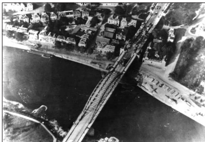
Luftbild der Lage: Vor der Brücke stehen zerstörte deutsche Panzer
